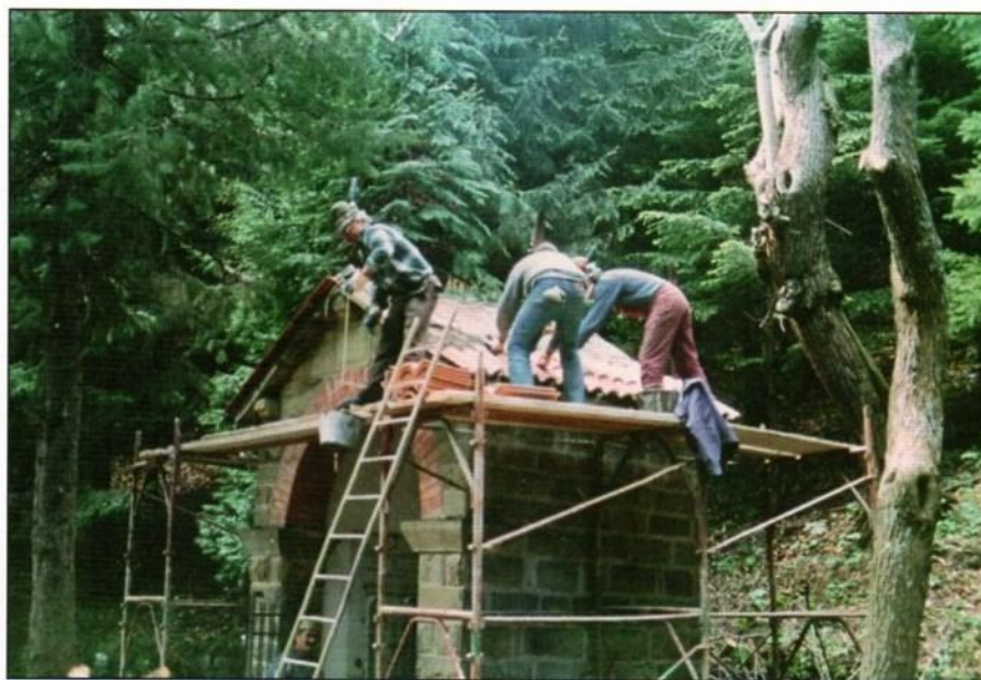
Alcuni momenti dell'impegnativo lavoro di ristrutturazione del "Monumento ai Caduti di tutte le Guerre" ad Alfero.
